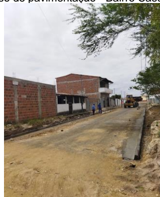
Imagem 3: Ruas em processo de pavimentação - Bairro Casulo - Conceição do Coité
